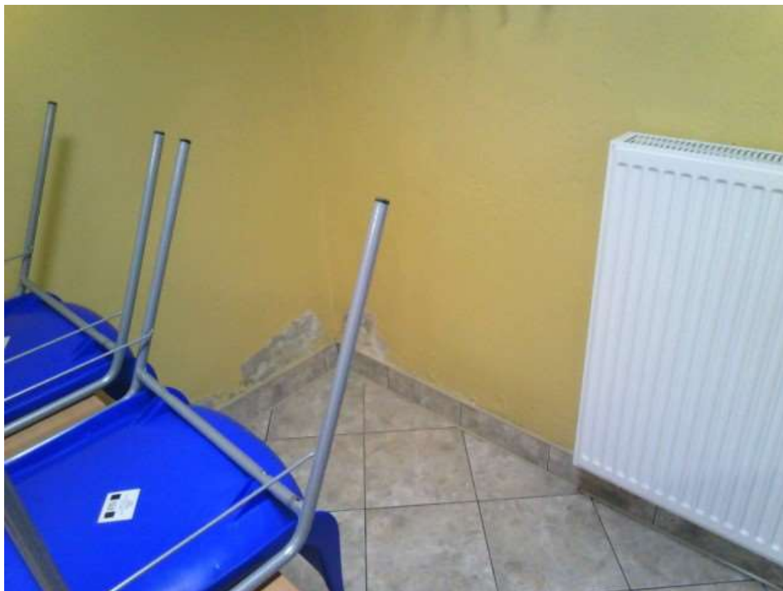
Fot. nr 8. Ślady po zawilgoceniu ściany w pom. stołówki
