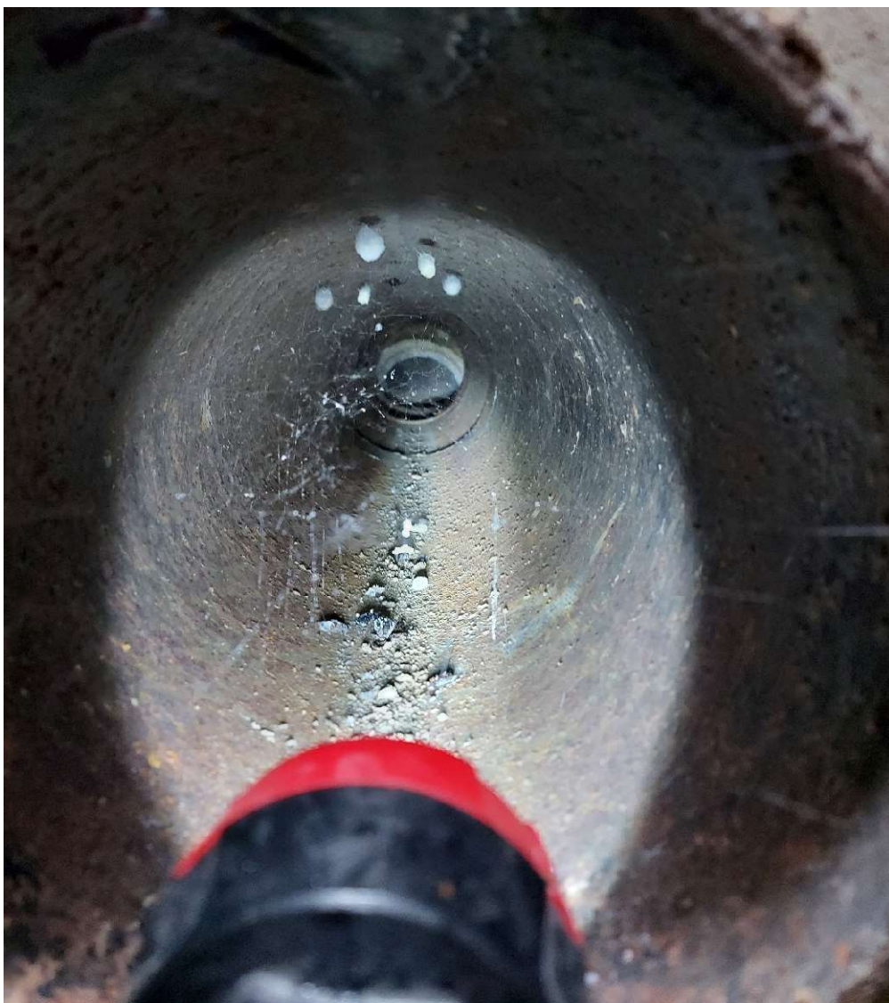
Fot. nr 13. Widok zapadniętej instalacji kanalizacji deszczowej
