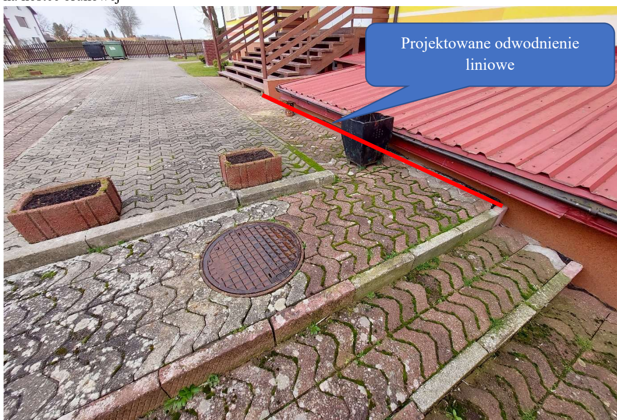
Fot. nr 17. Widok projektowanego odwodnienia liniowego na dziedzińcu, z wyprofilowaniem spadku na kostce brukowej
