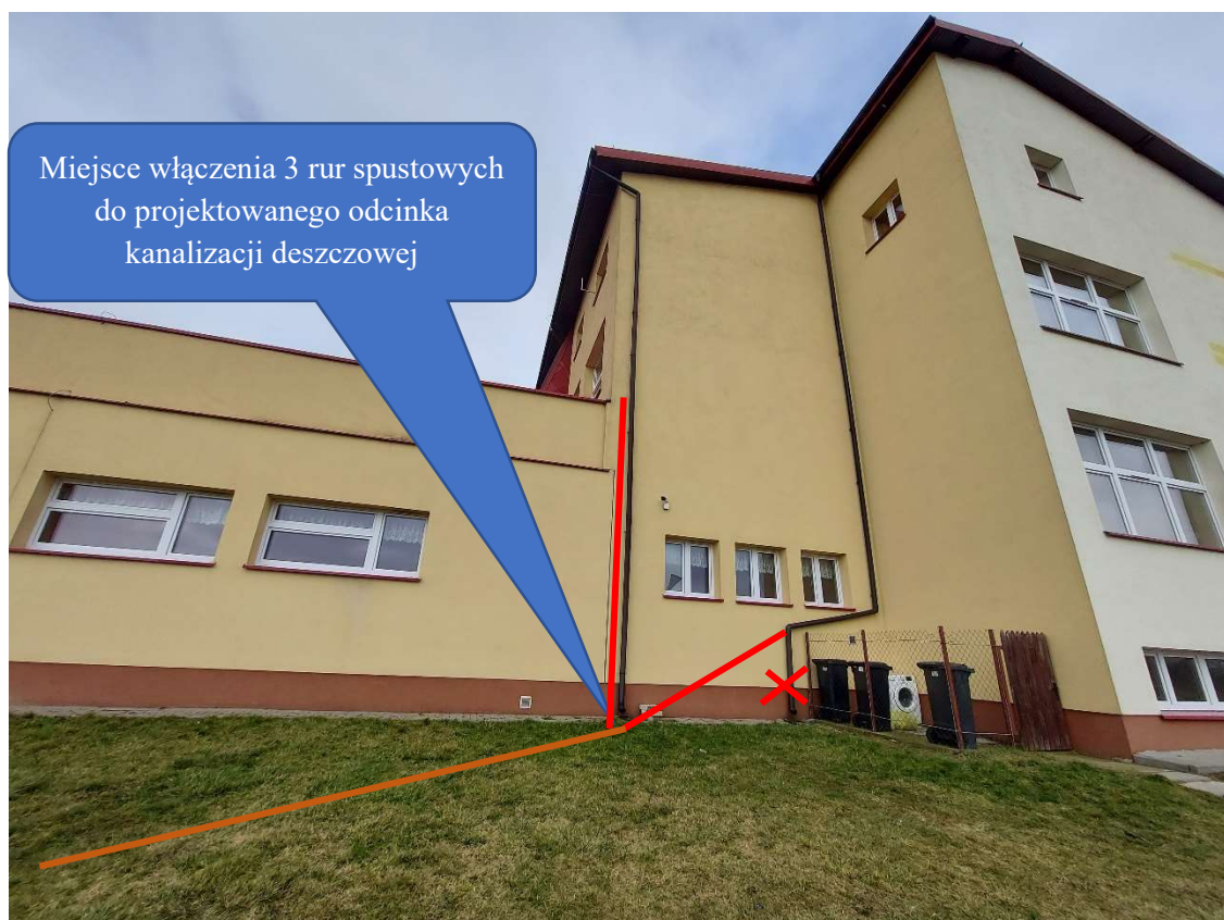
Fot. nr 15. Widok elewacji północno-zachodniej z propozycją włączenia rur spustowych do kanalizacji deszczowej
