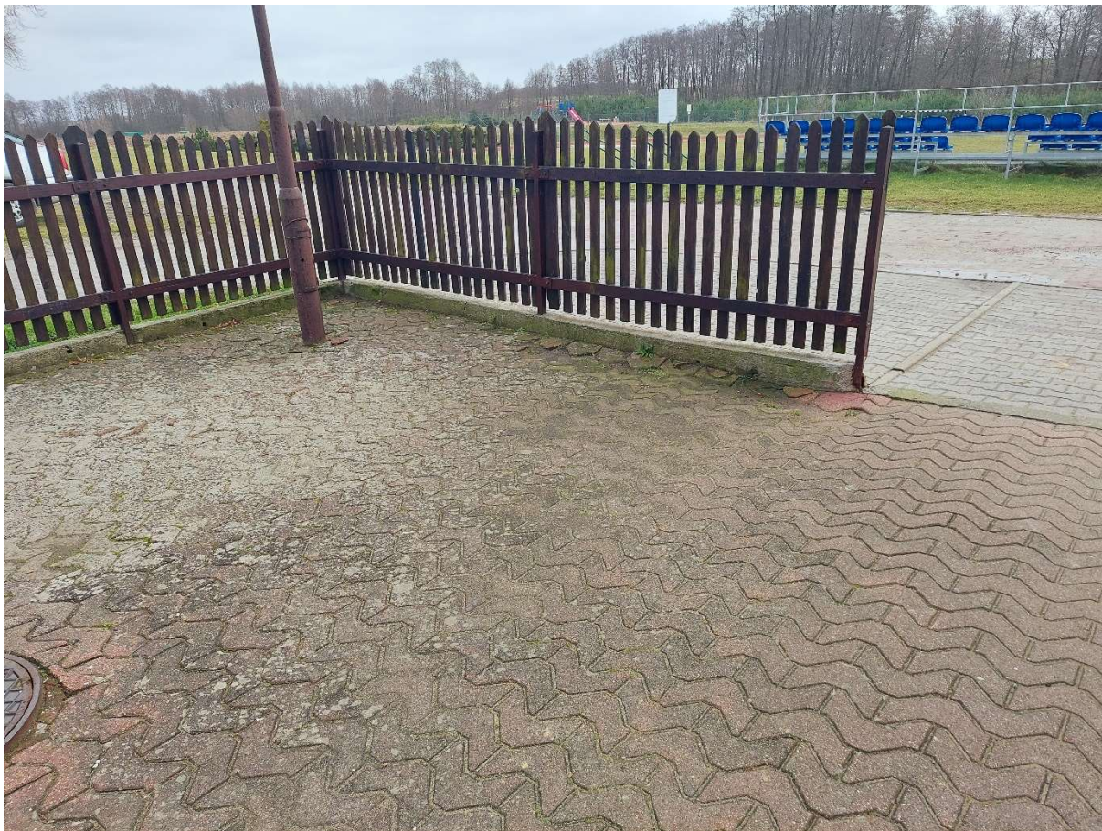
Fot. nr 2. Widok zapadniętego terenu w pobliżu kuchni w której nastąpił wyciek wody
