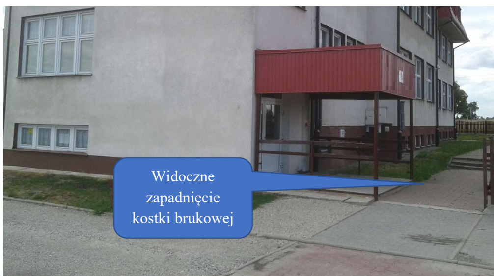
Fot. nr 14. Zapadnięcie kostki brukowej – zdjęcie z 27 lipca 2015 r.
