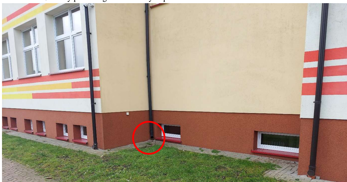
Fot. nr 9. Rura spustowa przy pom. stołówki – niepodłączona do instalacji kanalizacji deszczowej
