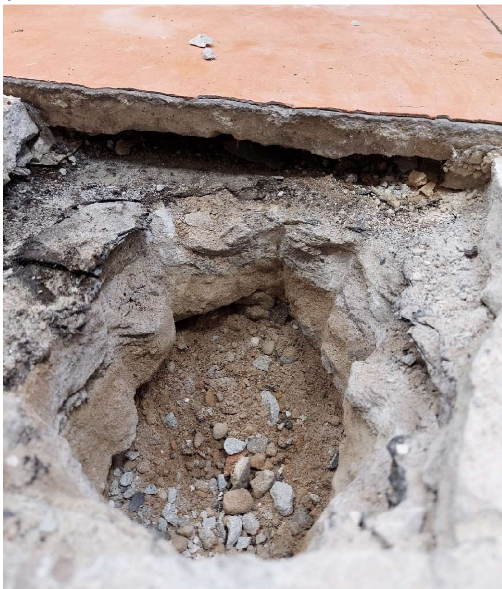
Fot. nr 4. Otwór badawczy nr 4 z widocznym pęknięciem posadzki
