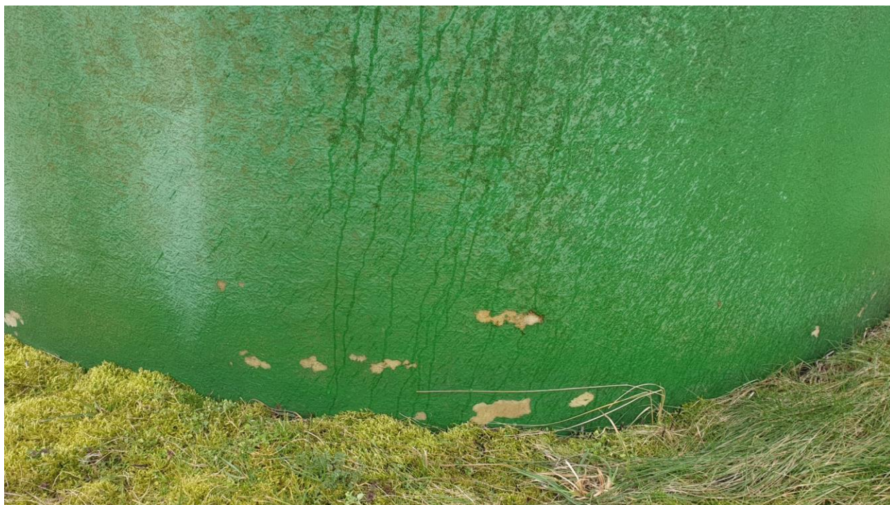
Uszkodzenia powłoki z laminatu
