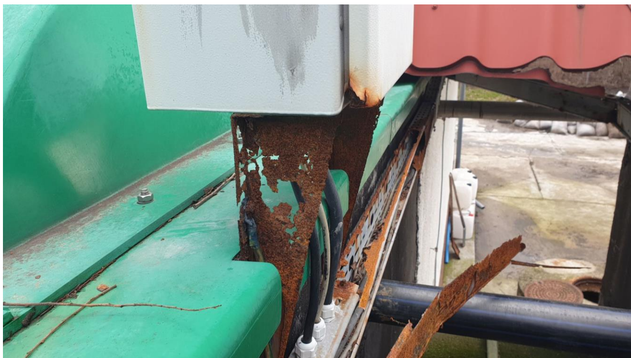
Korozja elementów wyposażenia
