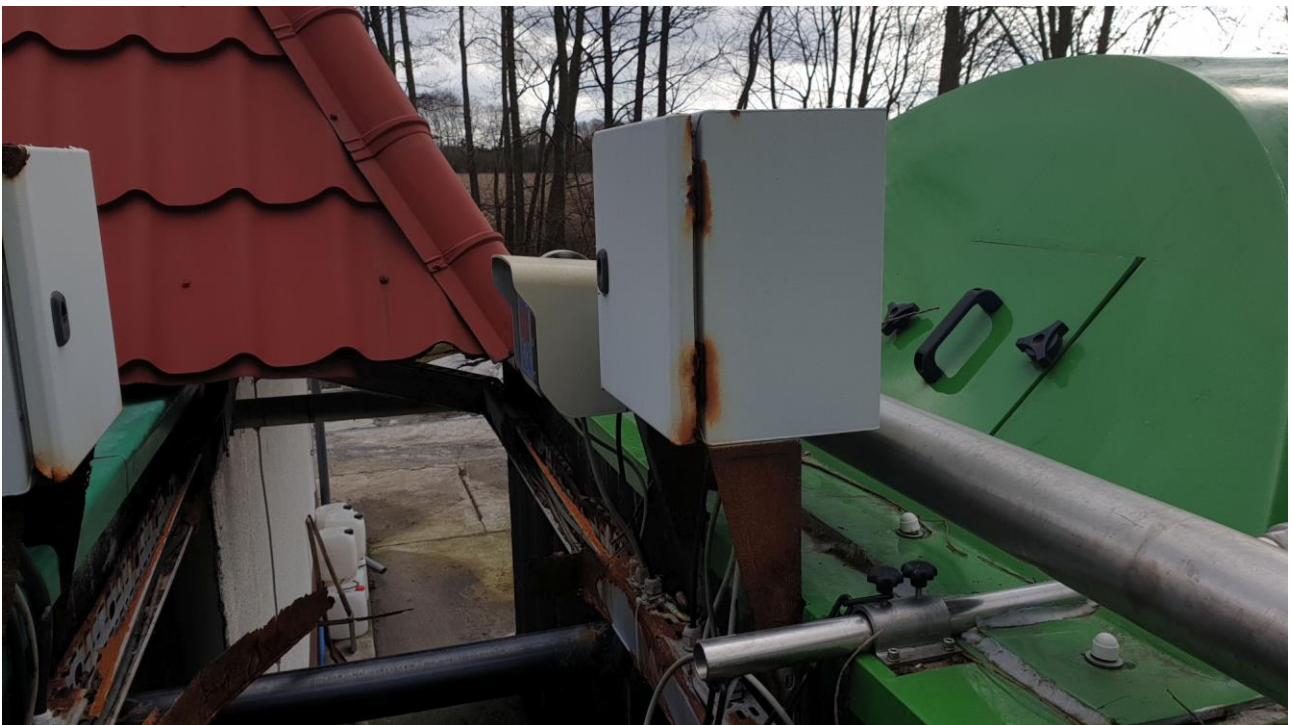
Korozja elementów instalacji elektrycznej
