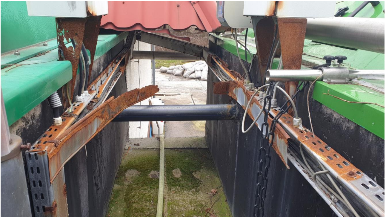
Korozja elementów instalacji elektrycznej
